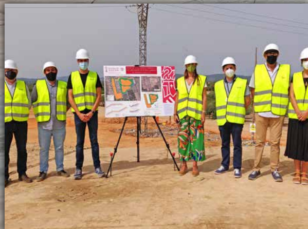
Obres de segellat de l'antic abocador
