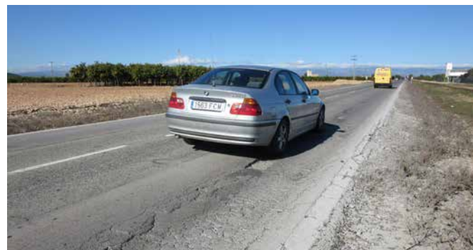
El estado de deterioro del vial va en detrimento de la seguridad
