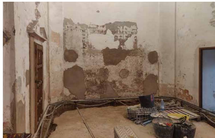
Les feines de rehabilitació de la capella continuen
