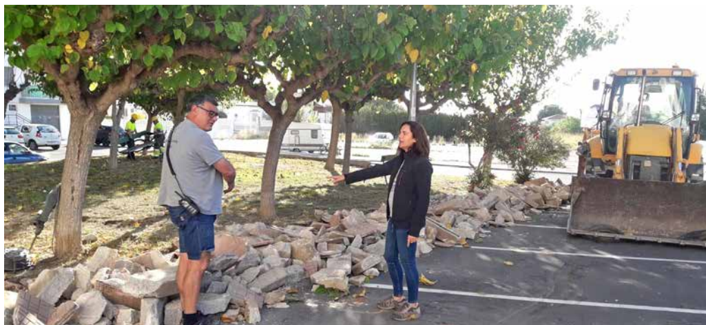
Les obres milloraran la seguretat viària i per a vianants
