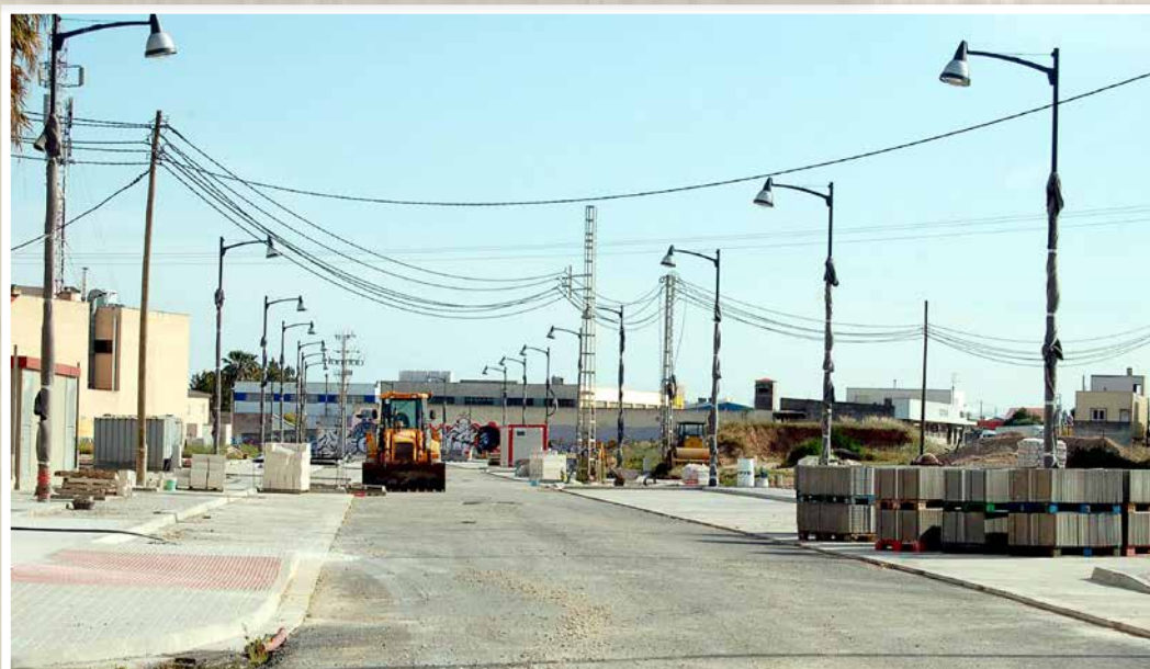
Començaven les obres del centre de coneixement Vinalab
