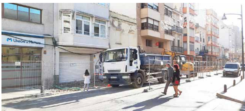
Imatge de les obres de renovació de la xarxa de sanejament del carrer de Sant Francesc i la rehabilitació de les canonades de l'abastiment de l'aigua potable. X.Flores
