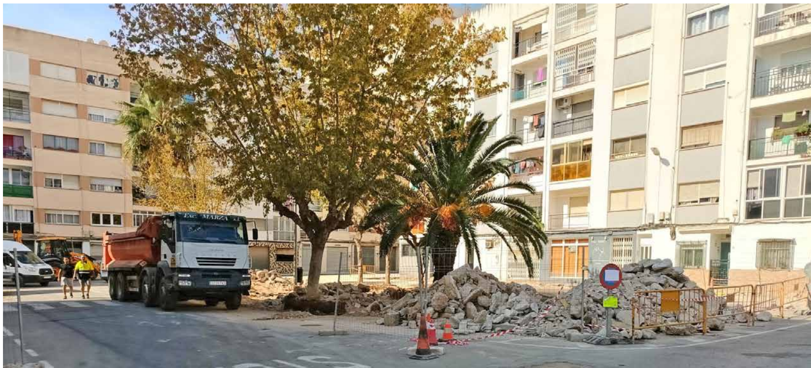
Les obres de la plaça de Sant Andreu reordenaran tota l'àgora
