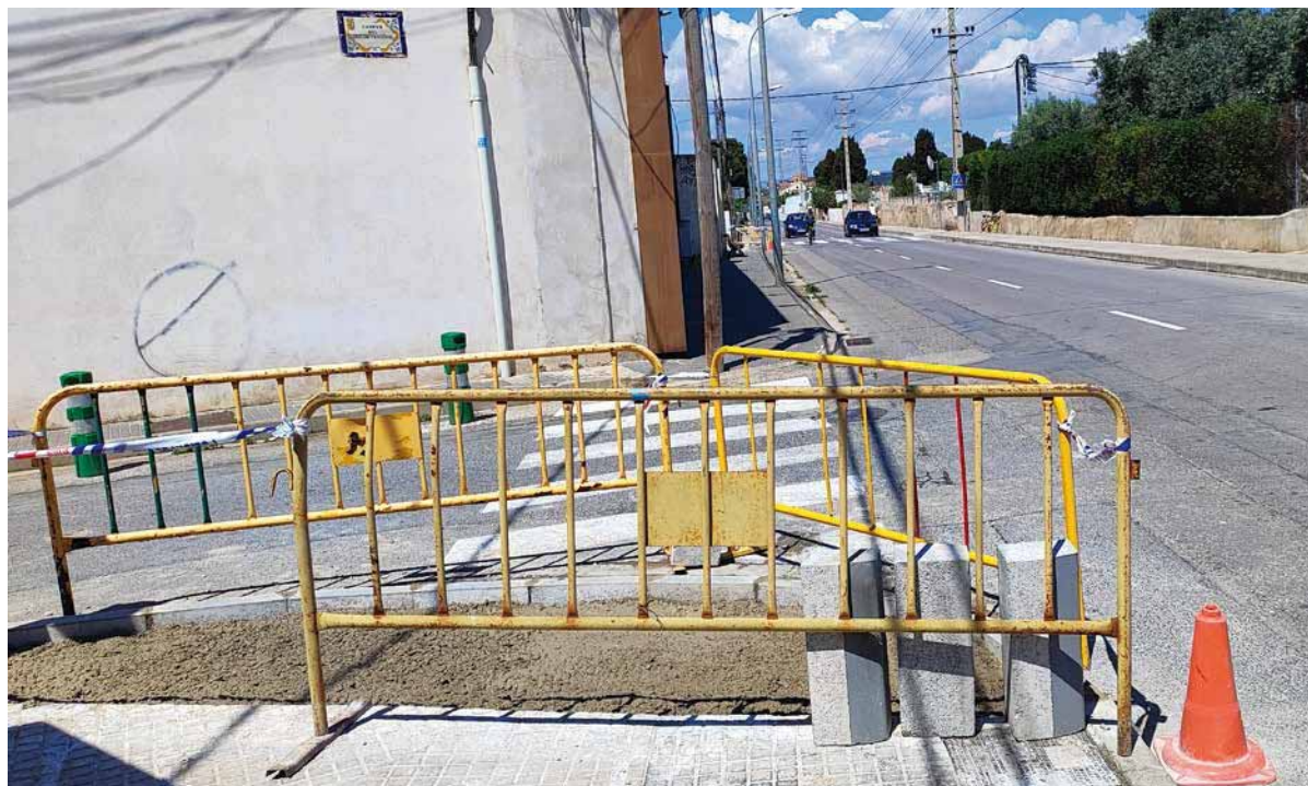
Uno de los cinco rebajes que se están realizando en el acceso al cementerio
