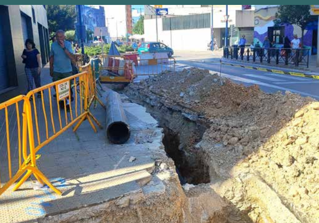
Canvis en la circulació per les obres de l'Avda Llibertat
